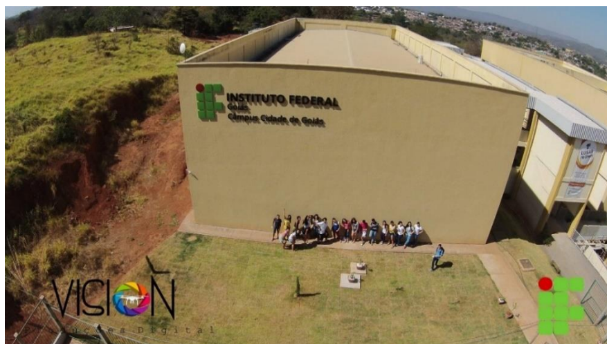
Figura 4 - Sede própria e atual do IFG Câmpus Cidade de Goiás
