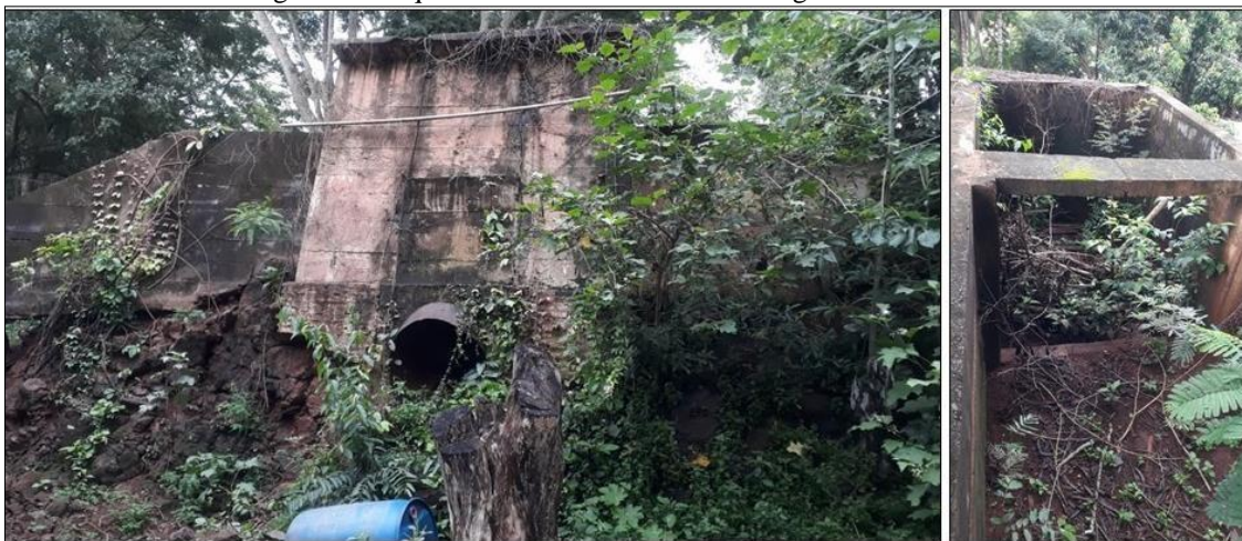
Figura 10: Pequena central hidrelétrica às margens do Rio Claro
