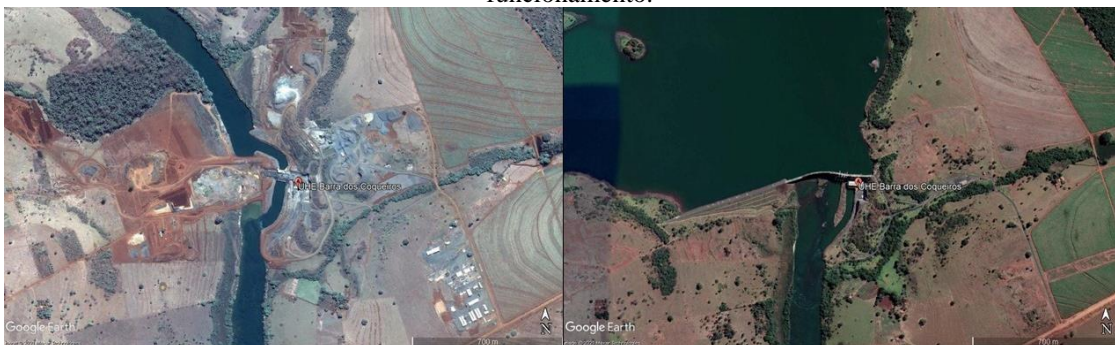
Figura 25: À esquerda, a usina hidrelétrica Barra dos Coqueiros em construção; à direita, já em funcionamento.
