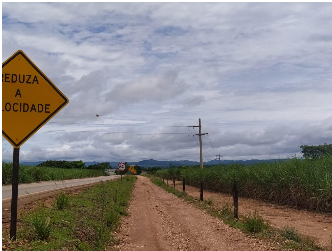
Figura 2 - Rodovia-GO 336, no município Nova Glória-GO
