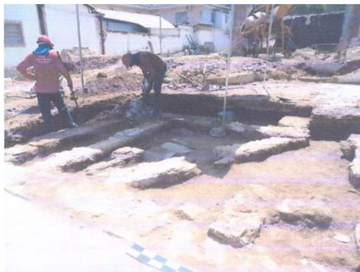
Figura 23 - Alicerces das residências anteriores à construção do Cine Teatro São Joaquim
