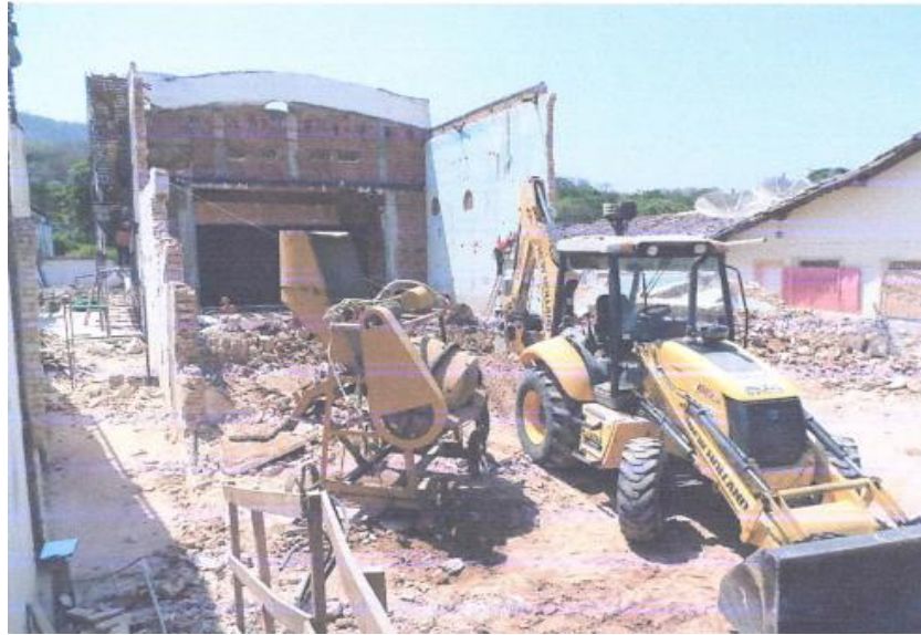
Figura 25 - Máquina retirando o entulho da demolição do Cine Teatro
