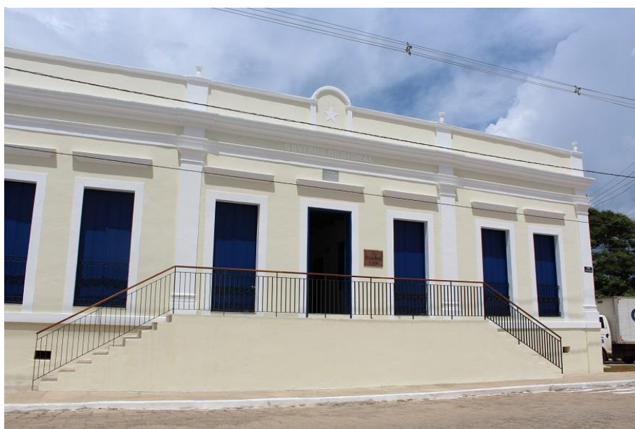
Figura 1 - Fachada restaurada da Prefeitura municipal de Goiás
