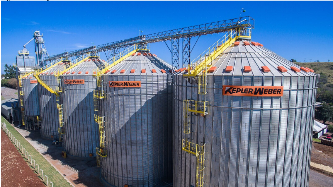
Figura 1 - Conjunto de Silos Metálicos.
