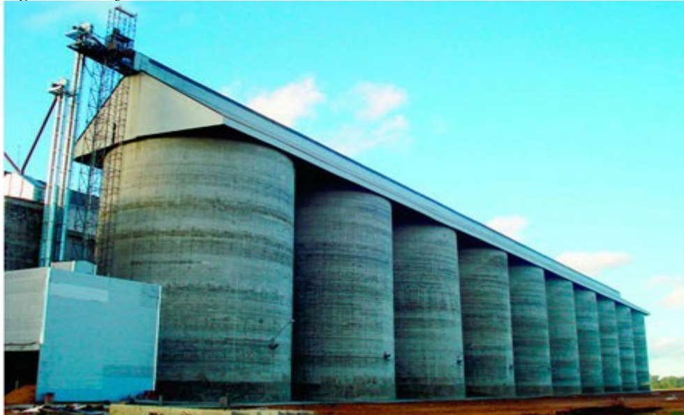
Figura 2 - Conjunto de silos elevados de concreto. Fonte: APROSOJA
