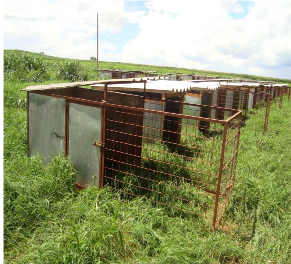
FIGURA 7 – Abrigo com cobertura de zinco galvanizado.
