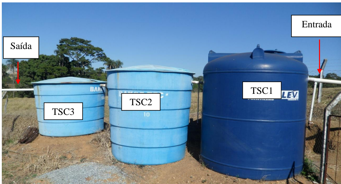
FIGURA 10. Tanques sépticos compartimentados em série.
