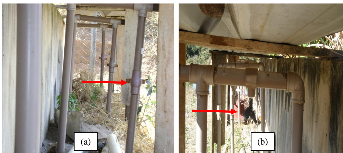
FIGURA 18. (a) Registros do tipo esfera para controle do fluxo nos leitos cultivados, (b) torneiras de coleta de amostras em cada leito cultivado.
