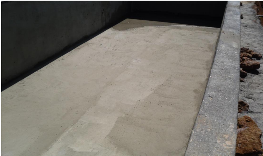
FIGURA 16. Leito vazio, construído em alvenaria e impermeabilizado, antes da colocação do meio de suporte e plantio.
