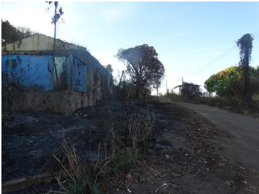
Figura 12 - Ruínas de casa e rua do bairro Santos Reis, no qual a população foi removida de maneira compulsória devido a expansão da mineração na cidade de Crixás
