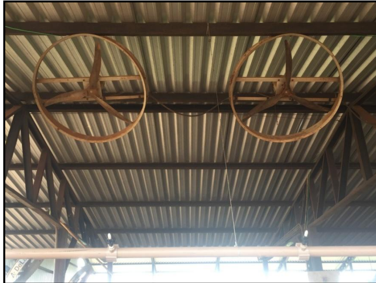
FIGURA 3 –Demonstração do SRAE - Sistema de resfriamento adiabático evaporativo, composto por dois ventiladores e dois bicos de aspersão, modelo canzil.
