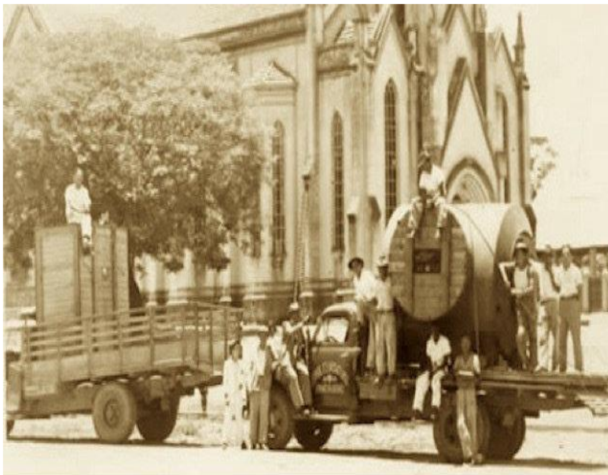
Figura 04 – Turbina da Usina Hidrelétrica “Rio Veríssimo”
