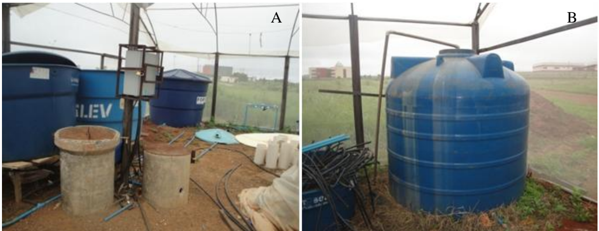
FIGURA 2. Reservatórios de polietileno para armazenamento da água do poço semi-artesiano (A) e do efluente da ETE/UnUCET/UEG (B).
