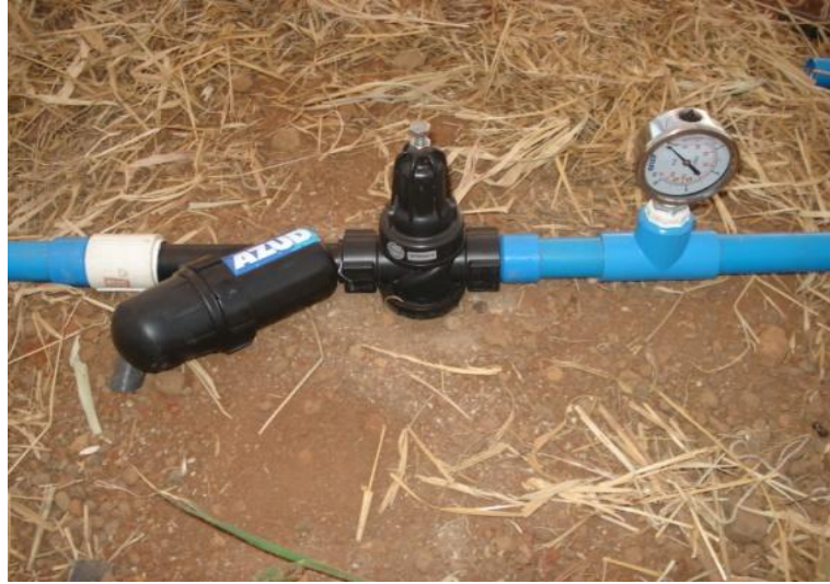
FIGURA 9. Filtro de disco de 120 microns, piloto regulador de pressão e manômetro com glicerina.
