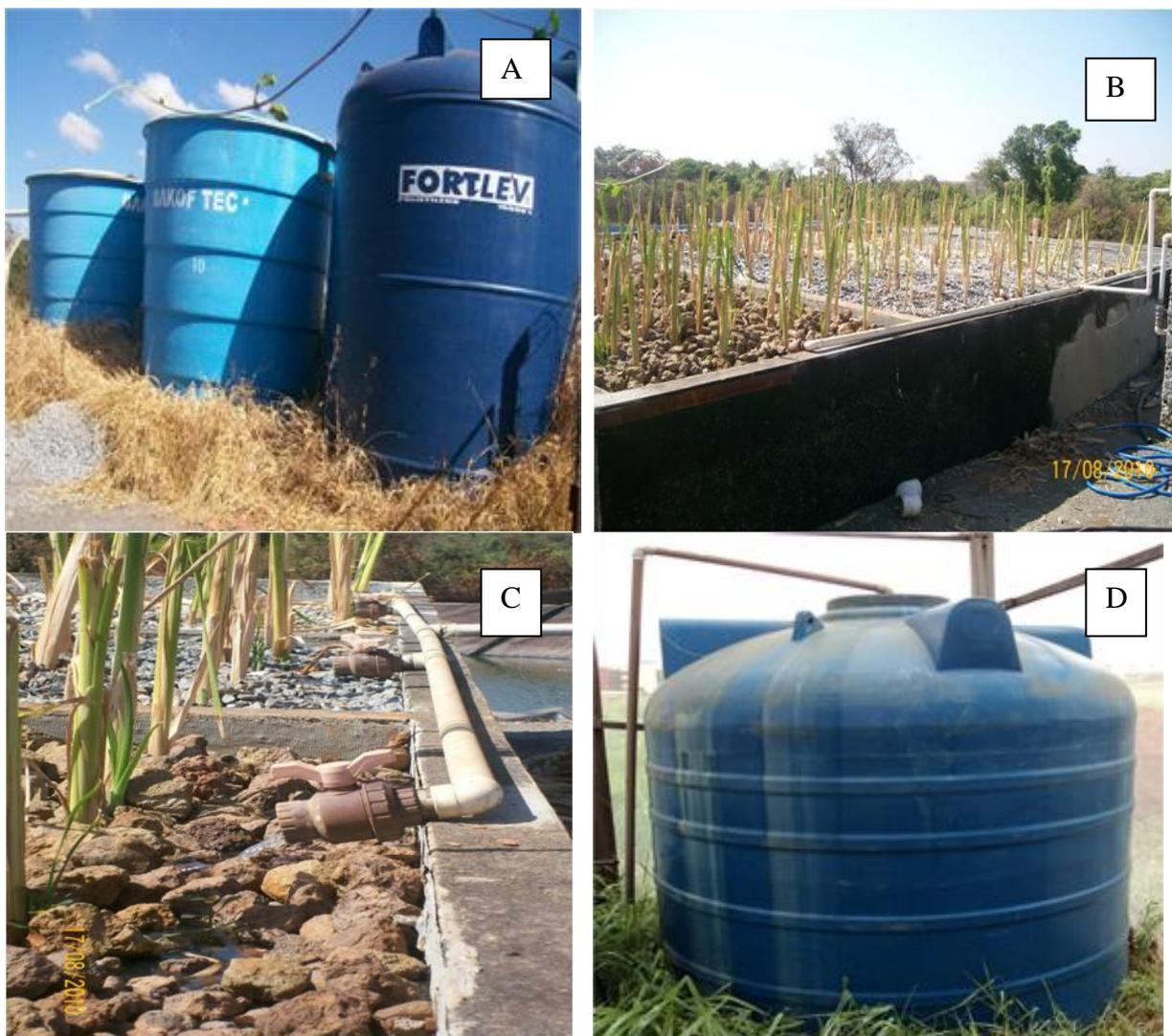
FIGURA 4. Vista dos tanques sépticos modificados em série (A), leitos cultivados com taboa (B), entrada do efluente nos leitos com fluxo subsuperficial (C) e caixa de armazenamento da água residuária no interior da casa de vegetação (D).
