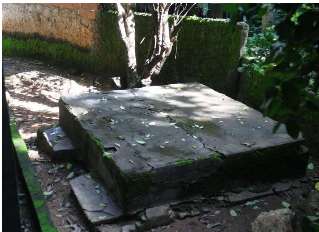
Figura 39: Poço original feito pela comunidade, localizado no terreno da Lavanderia Pública Santana (Foto: Fernando Arkanjo)
