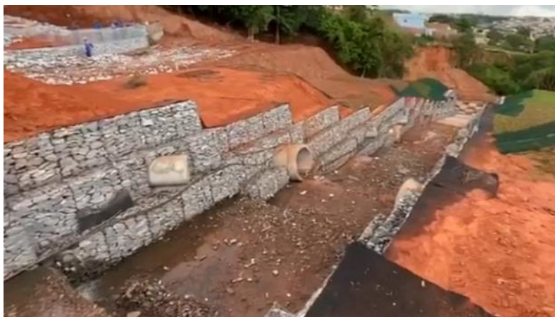
Figura 19 - Obras de contenção de voçoroca na Vila Formosa, Anápolis-GO
