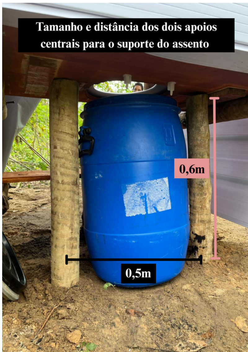
Fotografia 8 — Foto do tamanho e distância dos dois apoios centrais para o suporte do assento do banheiro
