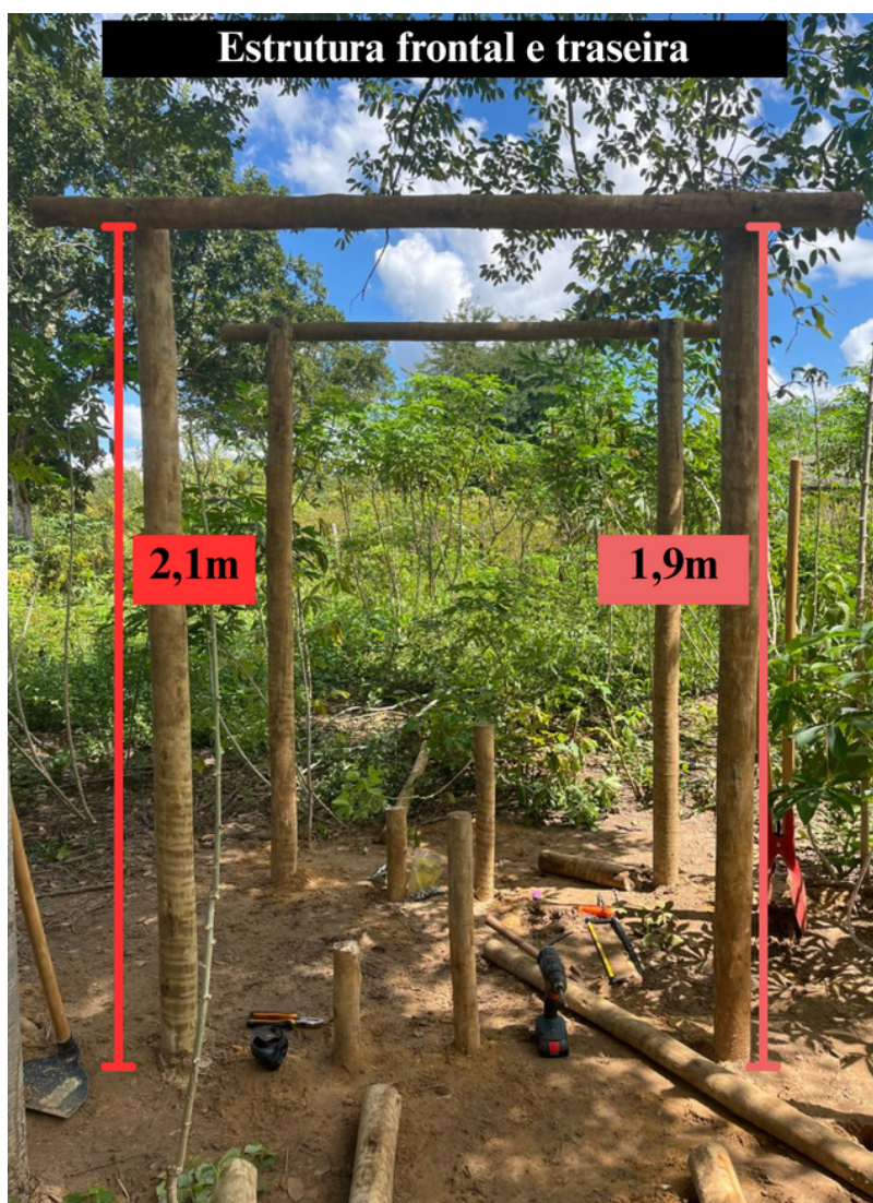
Fotografia 4 — Foto da estrutura frontal e traseira do banheiro
