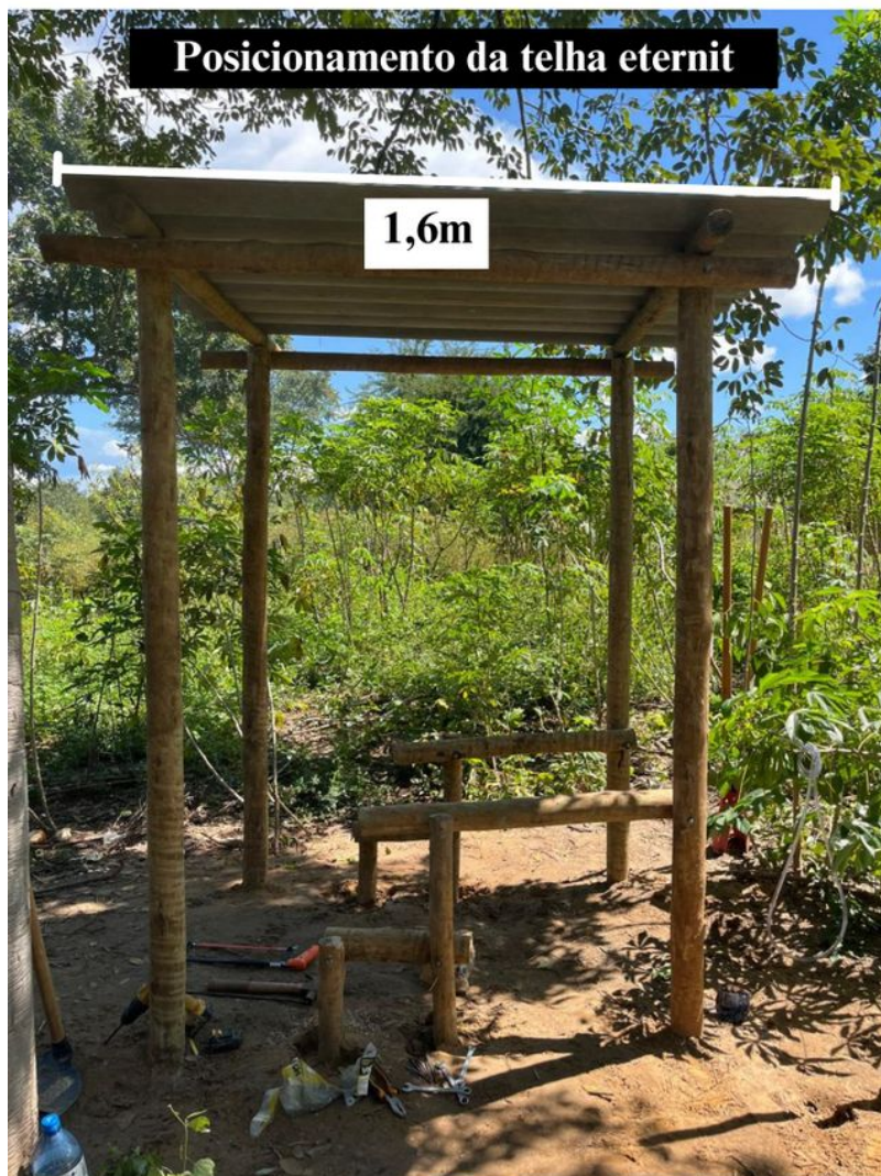
Fotografia 13 — Foto do posicionamento do telhado do banheiro
