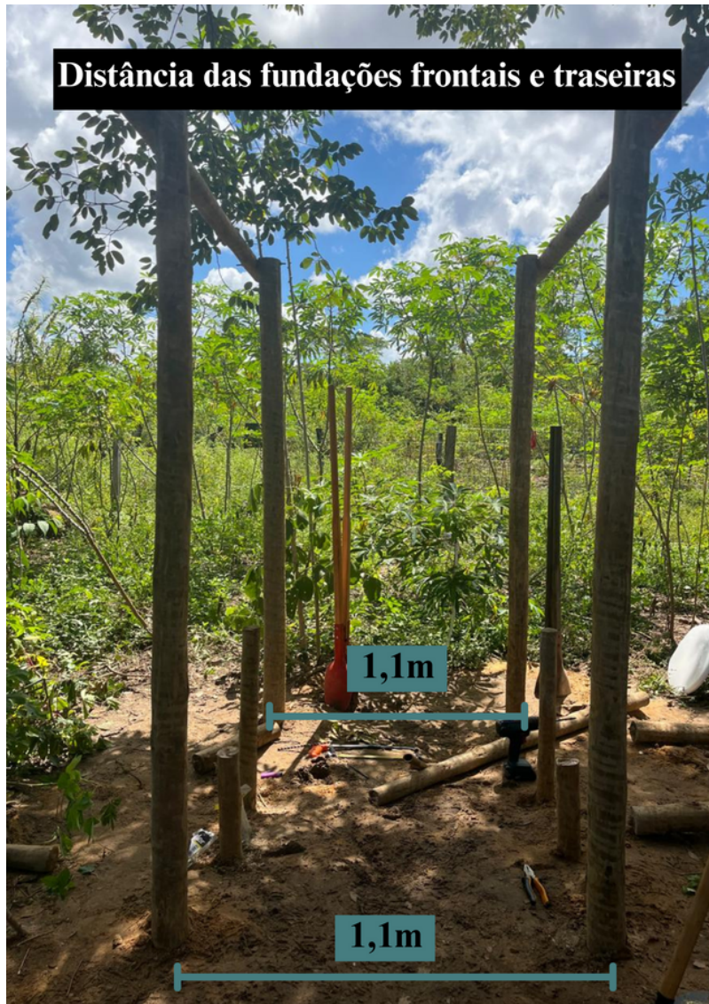
Fotografia 2 — Foto da distância das fundações frontais e traseiras do banheiro
