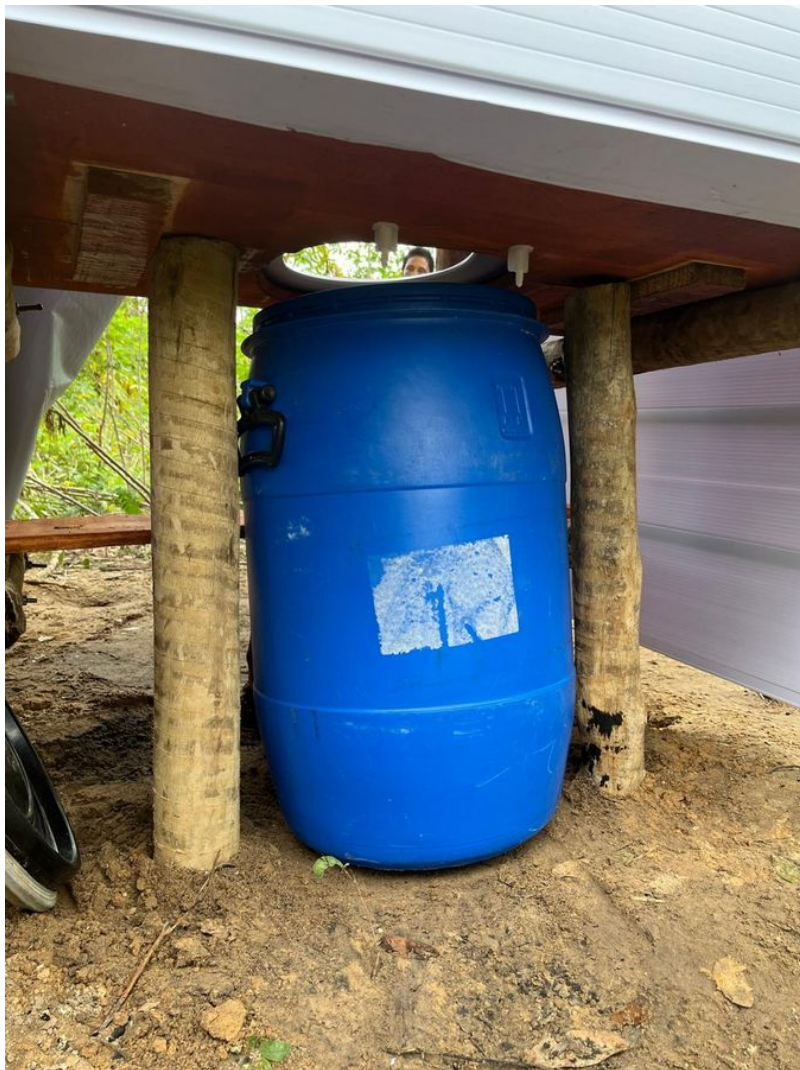
Fotografia 21 — Foto que ilustra a 1ª Etapa Quadro 8 - Estrutura do Banheiro Seco
