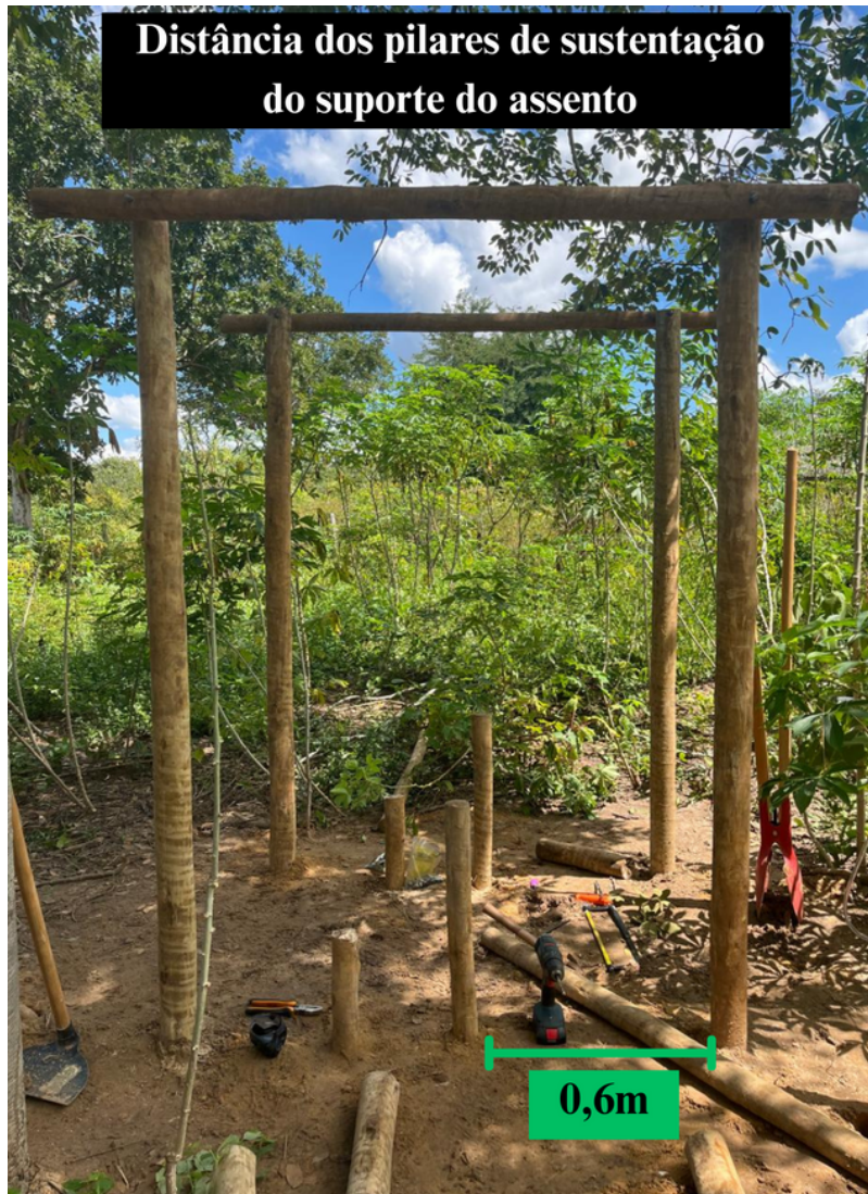
Fotografia 5 — Foto da distância dos pilares de sustentação do suporte do assento do banheiro
