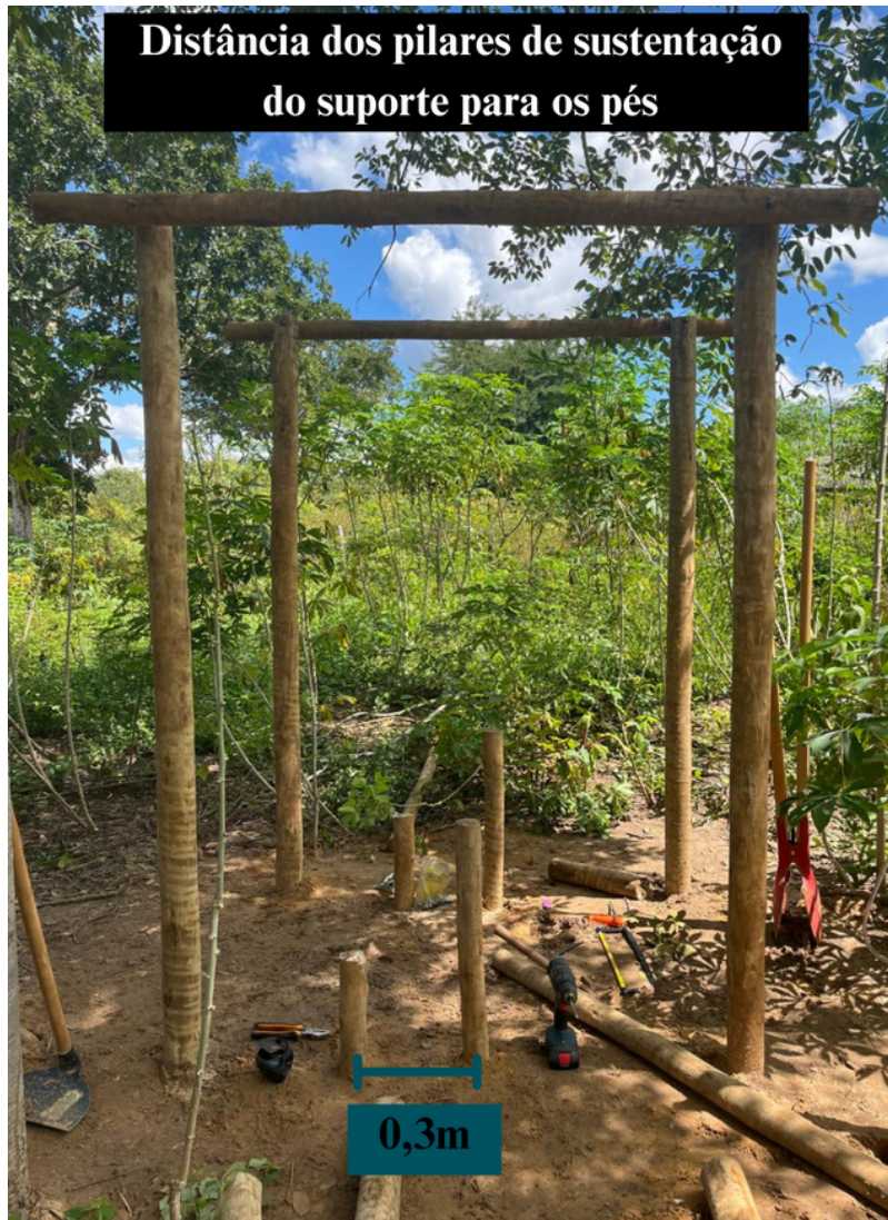
Fotografia 6 — Foto da distância dos pilares de sustentação do suporte para os pés do banheiro
