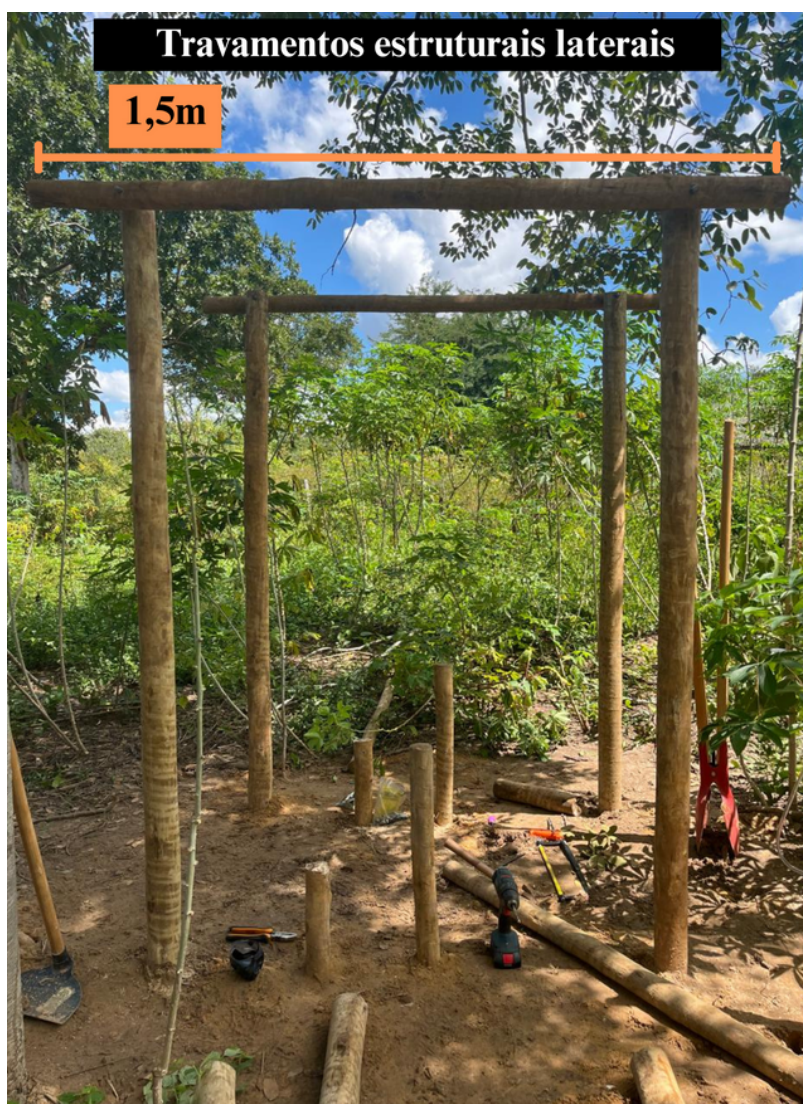
Fotografia 11 — Foto dos travamentos estruturais laterais do banheiro
