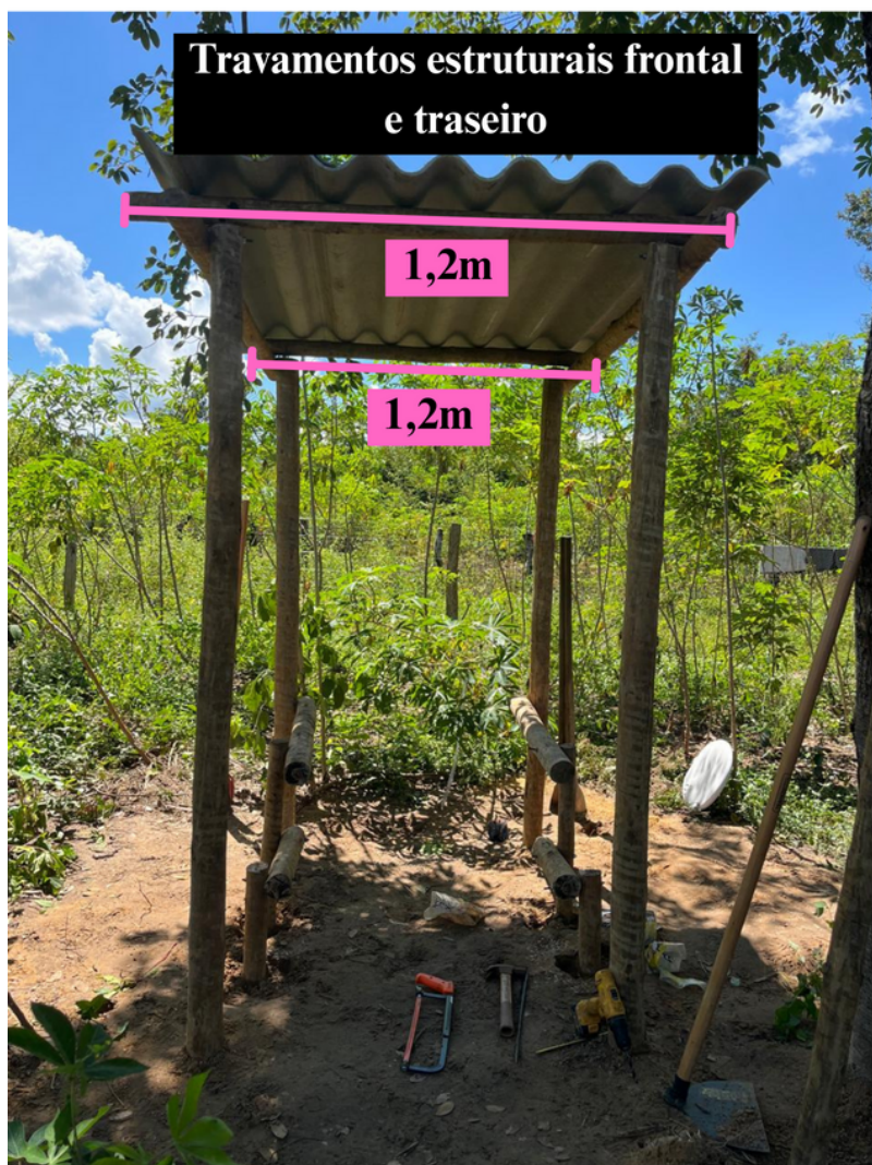
Fotografia 12 — Foto dos travamentos estruturais frontal e traseiro do banheiro
