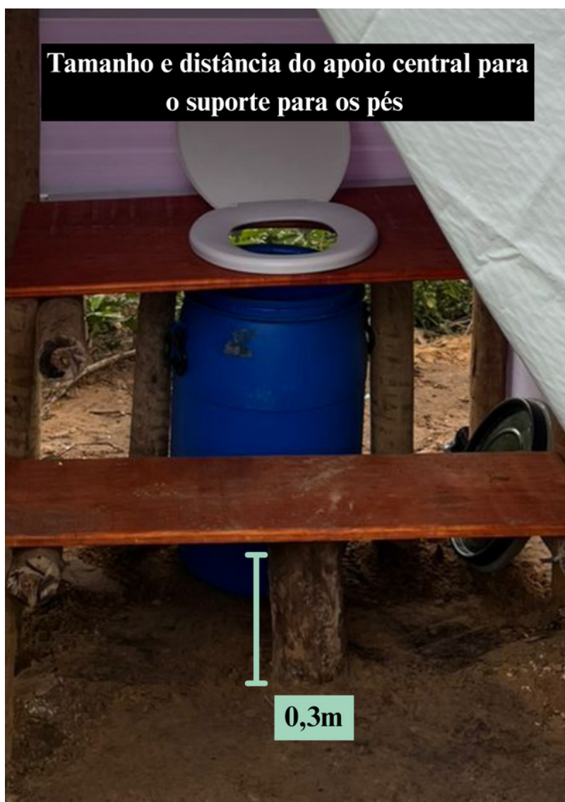
Fotografia 9 — Foto do tamanho e distância do apoio central para o suporte para os pés do banheiro
