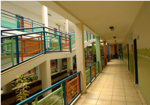
Figura 3 – Corredores de acesso às salas de aula
