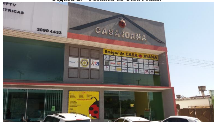
Figura 29- Fachada da Casa Joana.
