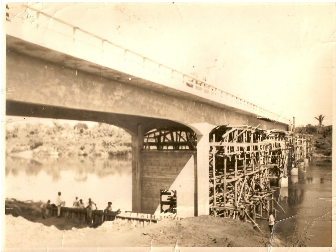
Ilustração 03 - Construção da ponte sobre os rios Araguaia e Garças.
