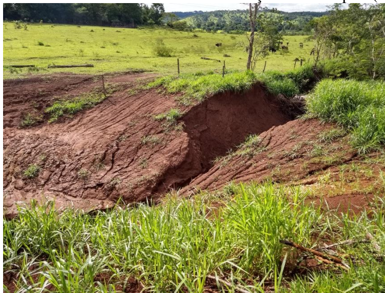
Figura 9 – Vista a montante do Barramento na Voco-roca do Capim (Janeiro 2018)
