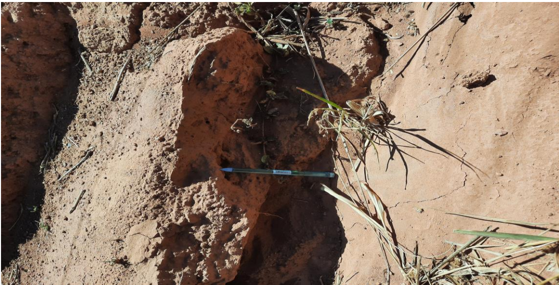
Figura 10 – Sulco a jusante do Aterro Controlado
