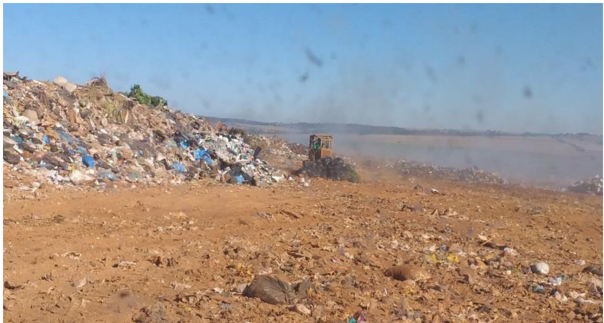
Figura 2 – Vista parcial do trator soterrando os resíduos sólidos no aterro controlado
