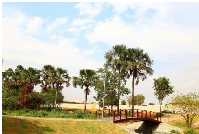
Figura 3: Trecho recuperado do córrego Macambira Anicuns em Goiânia.
