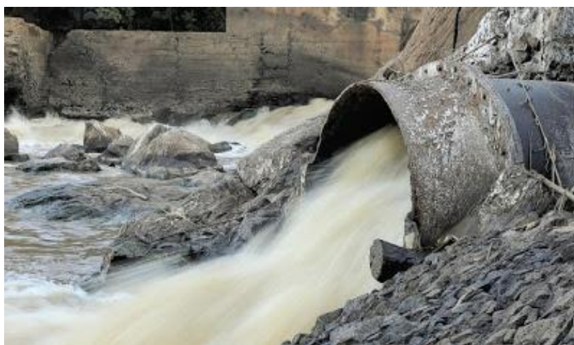
Figura 16: Esgoto jogado no rio Meia Ponte.
