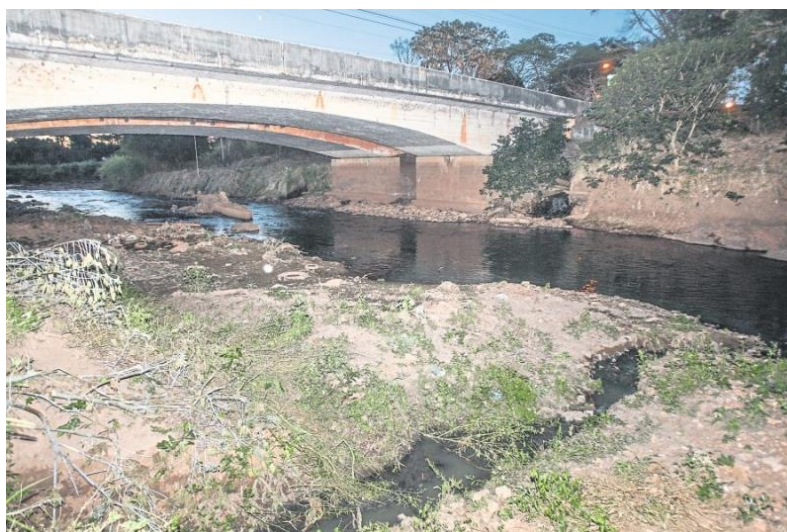
Figura 39: Trecho do rio no setor Balneário Meia Ponte onde se encontra esgoto clandestino.
