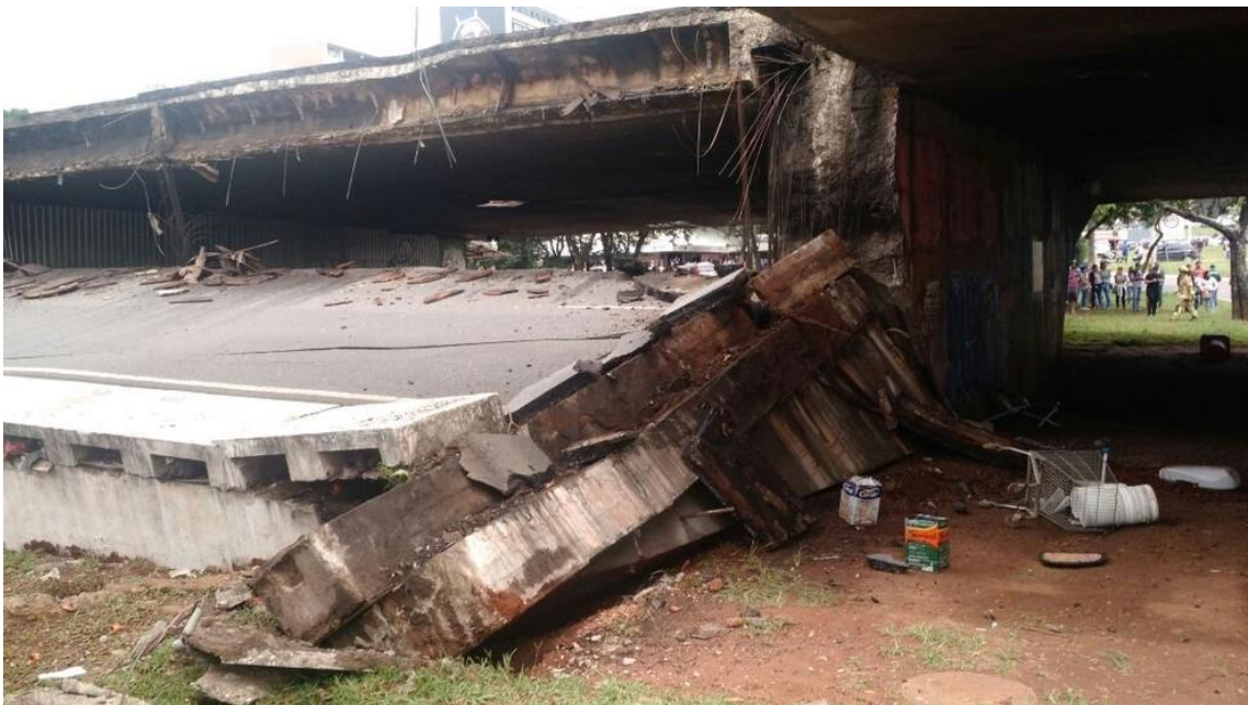
Imagem 2: Viaduto desabado no Eixo Rodoviário
