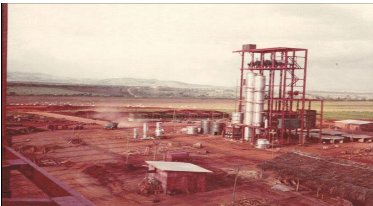
Fotografia 1 – Construção da Jalles Machado S/A em 1981.
