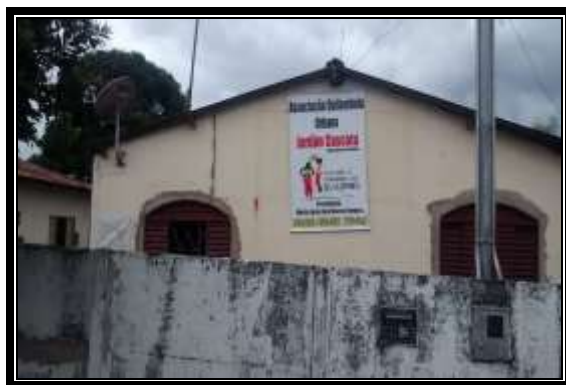
FOTO 4 - SEDE DA AQUJC – FACHADA FRONTAL –
